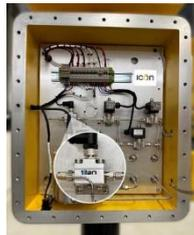
**Bildunterschrift** : Die Ovalrad-Durchflussmesser von Titan sind integrale Bestandteile der Online-Analysatoren für physikalische Eigenschaften von Icon Scientific, die hier im Zellgehäuse des Wolkenpunktanalysators von Icon zu sehen sind
